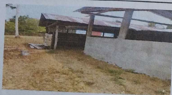
Foto 6: Se observa la falta de balcones y puertas metálicas del módulo .
